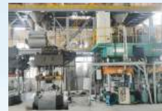
GRC地板生产车间
