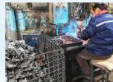
支架生产车间
