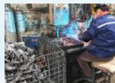
支架生产车间
